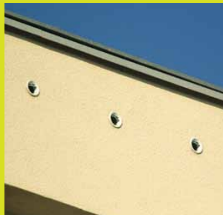
Atikové otvory prístupné pre dážďovníky aj po zateplení
